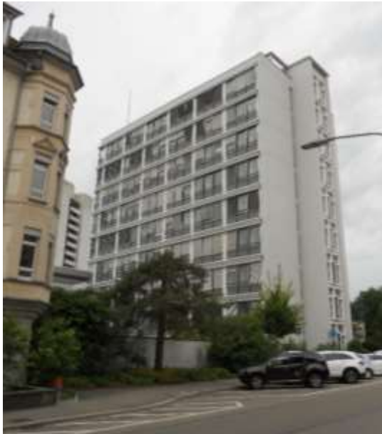
Das Hochhaus an der Plattenstrasse
