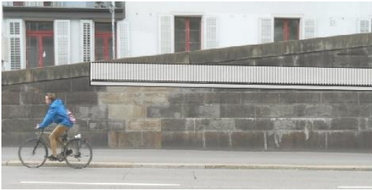
Die Stützmauer beim Heimplatz mit dem neuen Gehweg ein Geschoss höher.
