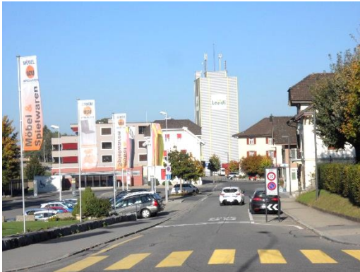
Die Bahnhofstrasse im Bereich Bus/Parkplatz
